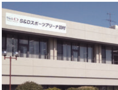
日影規制に抵触していることが判明したスポーツセンター
